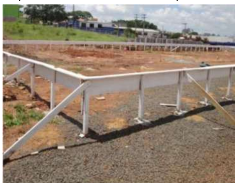
Figura 4 - Gabarito Esquemático de tábuas corridas pontaletadas, com travamento
